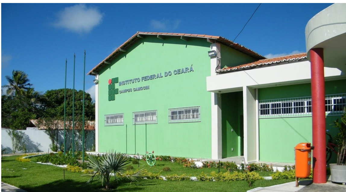
Figura 2.2 – Fachada do IFCE - Campus Camocim
